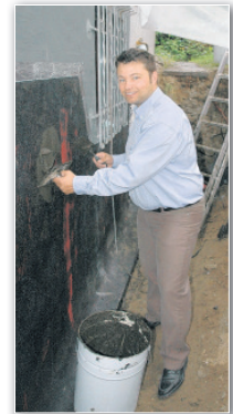
In besten Händen Holz- und Bautenschutztechniker Michael Hornig und sein Team verfügen über umfangreiches Fachwissen aus mehr als 2000 Sanierungen
